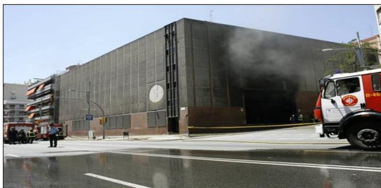
Figura 2. Incendio en Maragall, Barcelona. Avería en una terminación de cable.
