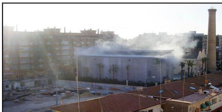
Figura 3. Explosión en Patraix, Valencia, por motivos de avería en cables de AT. Avería en una terminación de cable.
